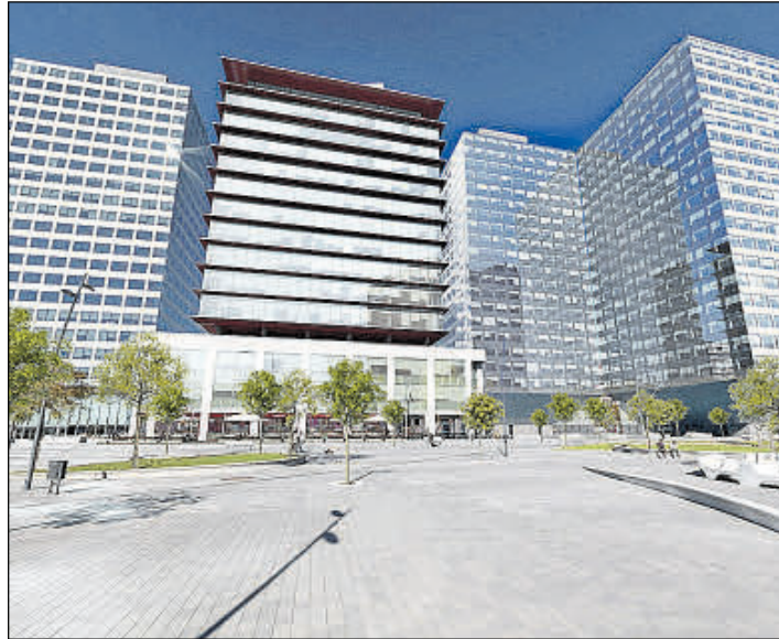
Complejo de cuatro torres de Iberdrola Inmobiliaria en BcnFira District. EE
